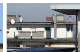
Le câble d'alimentation sur le toit
