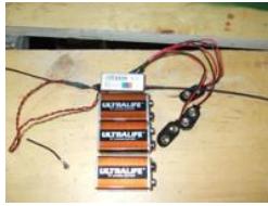
L'ensemble démonté. Les piles étaient déchargées.
