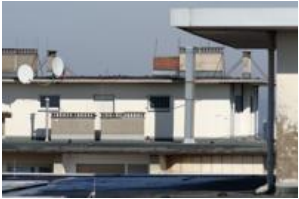
Le câble d'alimentation sur le toit
