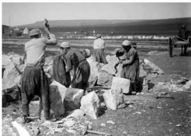
Robotnicy w okolicach Aleppo w Syrii podczas budowy linii kolejowej, która według założeń planistów miała prowadzić z Berlina do Bagdadu.
