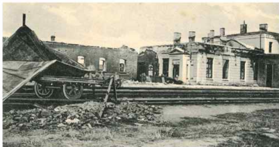
Dworzec kolejowy w Kaliszu zniszczony w wyniku działań wojennych w 1914 r. Walki na ziemiach polskich oraz rabunkowa polityka państw centralnych spowodowały ogromne straty materialne, która później utrudniały odbudowę gospodarki II Rzeczypospolitej.
