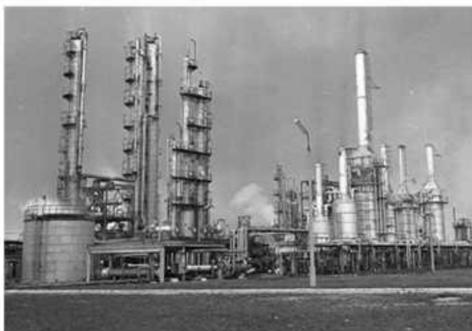
Rafineria w Płocku została zbudowana w latach 1960–1965 na mocy porozumień zawartych przez PRL w ramach RWPG.
