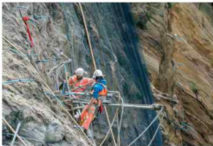
Zabezpieczanie dróg zagrożonych ruchami masowymi wymaga kosztownych prac geotechnicznych. Podczas ich wykonywania często stosuje się techniki alpinistyczne.
