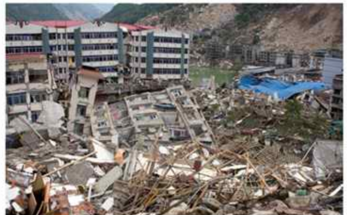
W chińskim mieście Beichuan w 2008 r. w wyniku trzęsienia ziemi o magnitudzie 8 uległo zniszczeniu ok. 80% budynków.
