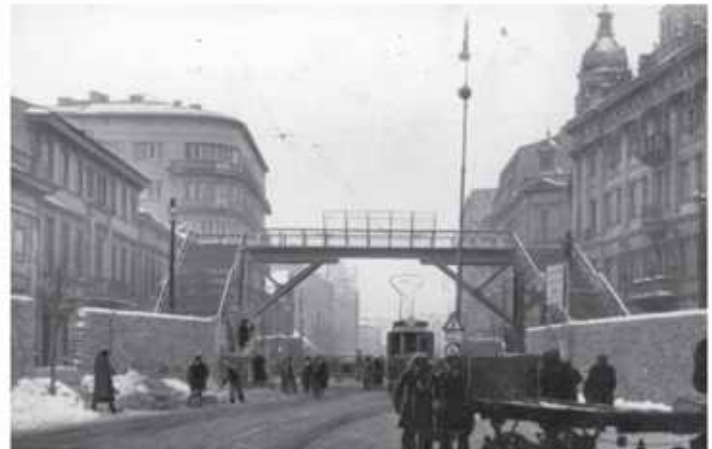
Drewniana kładka nad ulicą Chłodną, łącząca Małe i Duże Getto (zdjęcie retuszowane)
