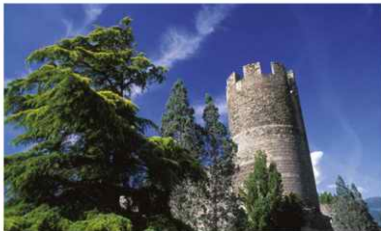
Wieża Bramafan, Aosta
