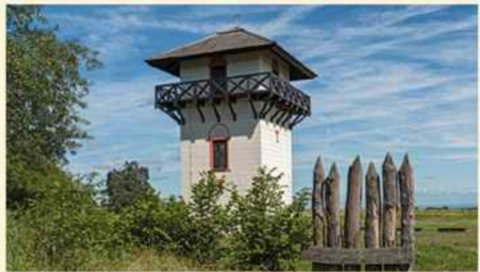
Rekonstrukcja wieży obserwacyjnej , której niewielka załoga śledziła wydarzenia na przedpolu muru. Obiekty takie na Wale Hadriana wznoszono co 500 m.
